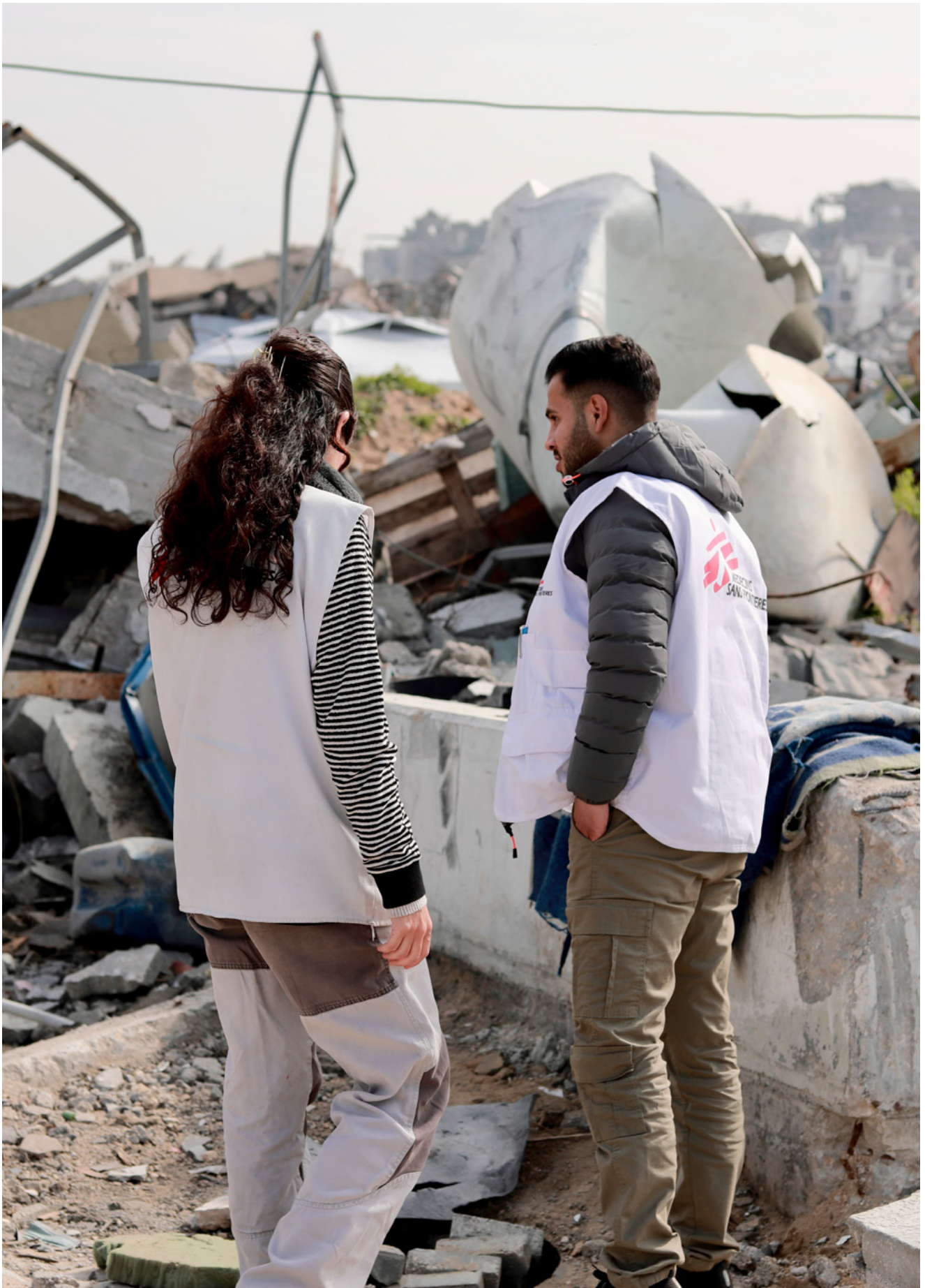
↑ Onze ingenieurs op het gebied van water- en sanitaire voorzieningen bekijken beschadigde waterleidingen in de stad Beit Lahia. Gaza, maart 2025. Foto: Nour Alsaqqa/AzG
